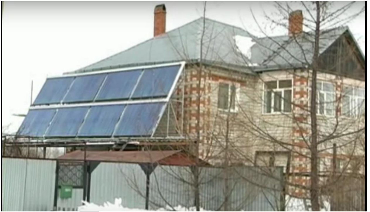
Рисунок 2.3. Установка солнечных коллекторов
